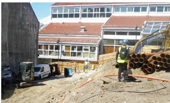
Figur 2: Tomta for Zara-huset etter rivingen av bygget til Norem Baade i 2014.
