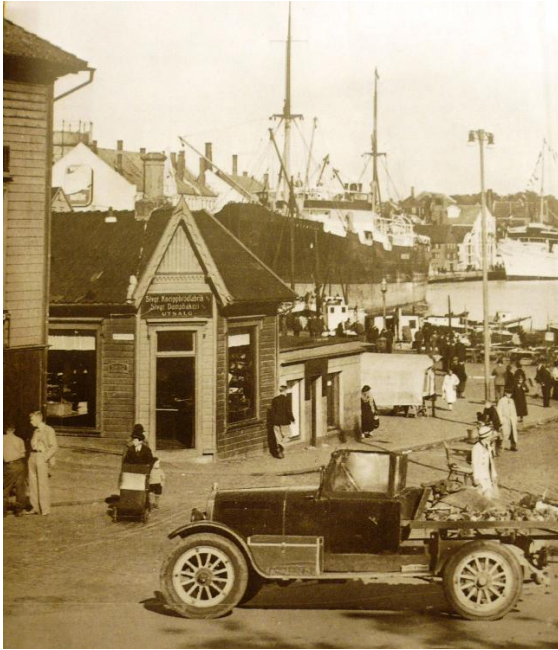
Figur 3: Dampbakeriet på hjørnet ved inngangen til Nedre Strandgate fra Torget. 19 Fotografen er ukjent.
